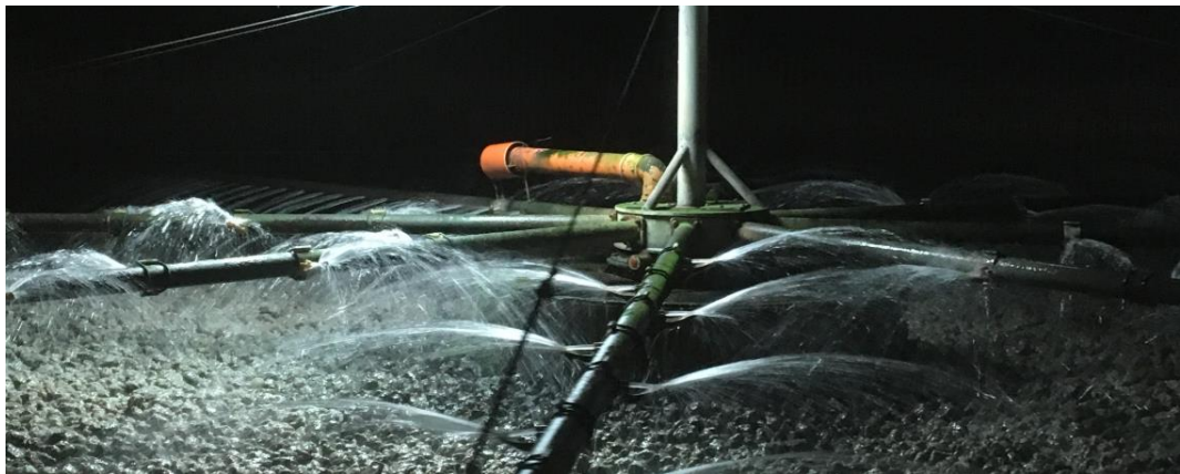
Abbildung 2-1 Tropfkörperverfahren KA Kirchdorf
